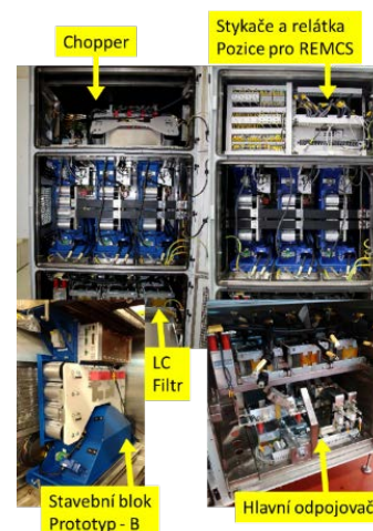
Obr. 6 - Výzbroj skříně s výkonovými měniči – soustava základních stavebních bloků 150 kVA
